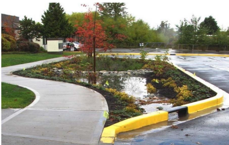
Rys. 36 Przykład zastosowania ogrodów deszczowych na parkingach jako systemu zagospodarowania nadmiaru wody deszczowej.
